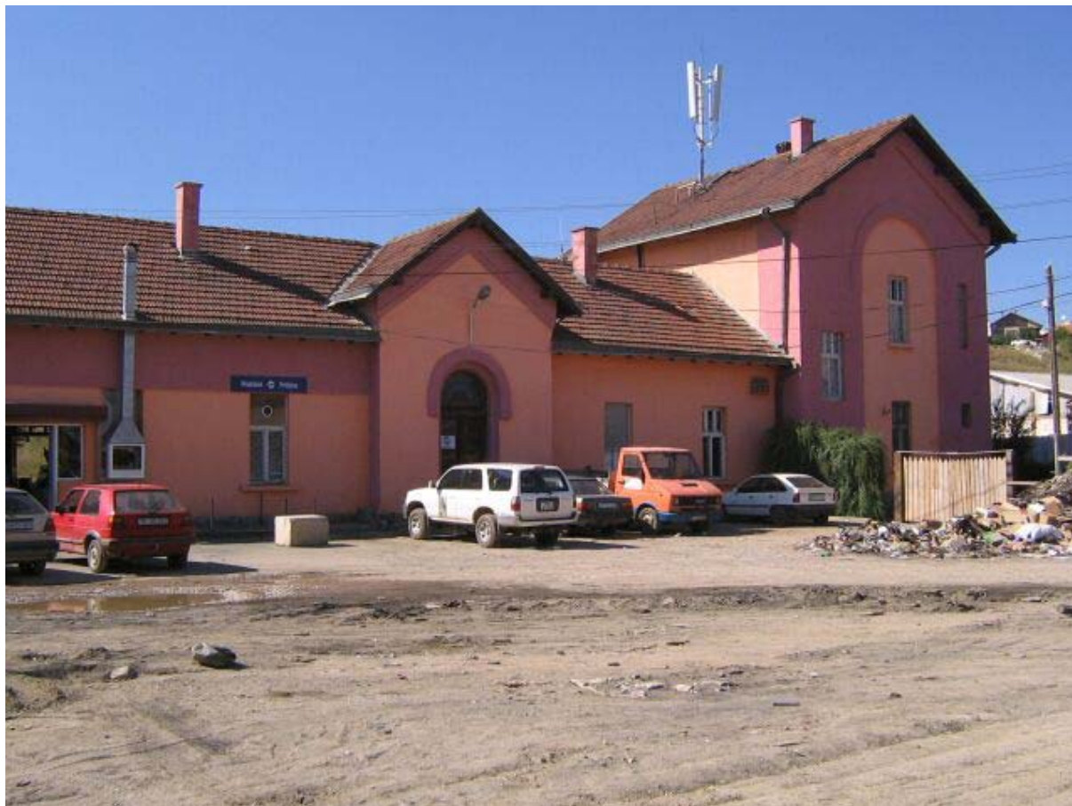
Abbildung 1: Hauptbahnhof Pristina - Straßenansicht
