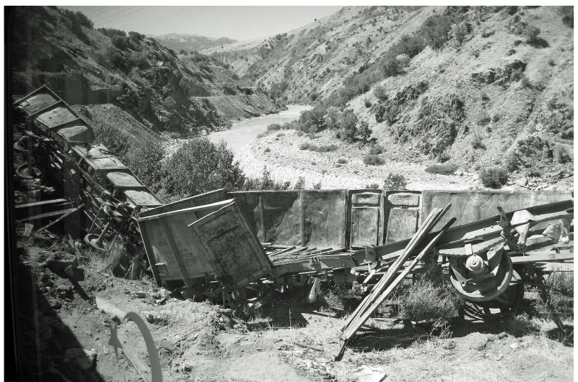
Trümmer eines verunglückten Güterzuges im wilden Flusstal des Murat Yeri, einem Nebenfluss des Euphrat. (6.9.12)
