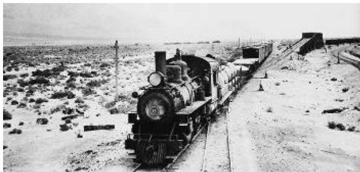
Die Nr. 18 passiert die Transferstation Owenyo. (Samml. TE)
