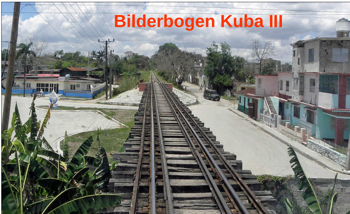
Fahrt über die Yayabo-Brücke in Sancti Spiritus – der Fluss selbst ist schon überquert!
