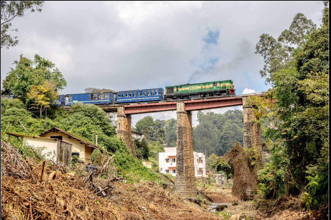
Auf dem Viadukt von Wellington ist die YDM4 - 6664 zu sehen. Dass der Hang unter dem Viadukt die örtliche Müllkippe ist, erkennt man auf dem Bild nicht. (Beide Fotos: Thomas Franke)
