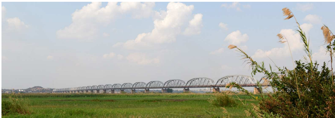
Die Länge der Ponte Dona Ana bei Vila de Sena ist beeindruckend! Die 3.543 Meter lange Brücke besteht aus 40 stählernen Fachwerkbögen sowie einer Vorlandbrücke. Im Hintergrund liegt der Ort Nova Mutarara, unter den letzten 15 Bögen fließt der Sambesi.
