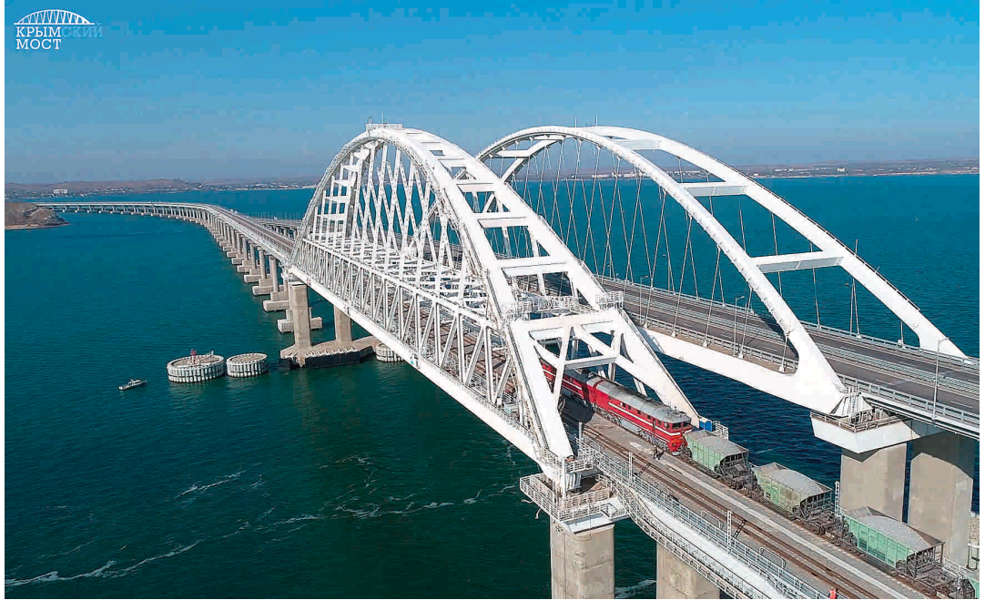
Luftaufnahme der neuen Krimbrücke, Quelle des Fotos: www.most.life ( https://www.most.life/multimedia/foto/zheleznodorozhnye-konstrukcii-krymskogo-mosta-ispytyvayut-tyazheloj-nagruzkoi/ )
