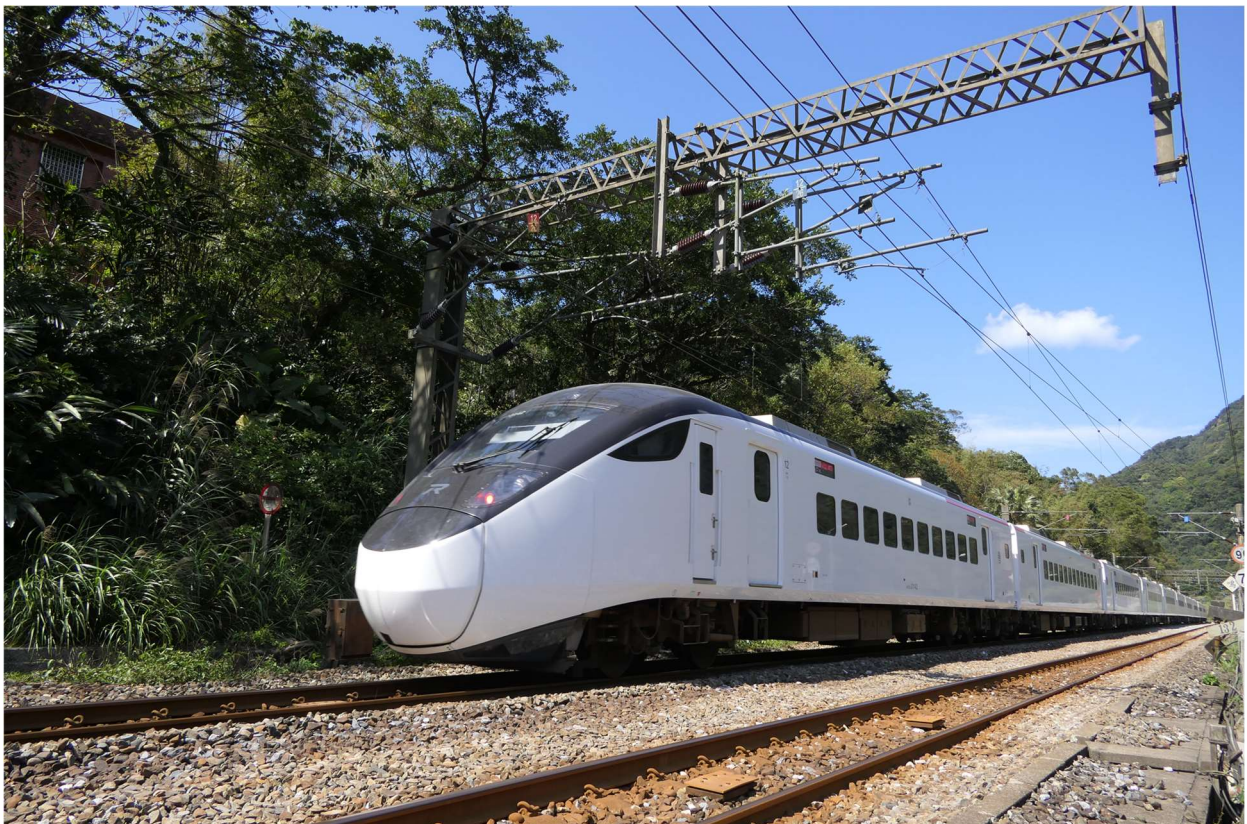
So sieht der moderne Verkehr der TRA heute aus. Der bei Hitachi Rail in Japan gebaute EMU3000 fährt durch
